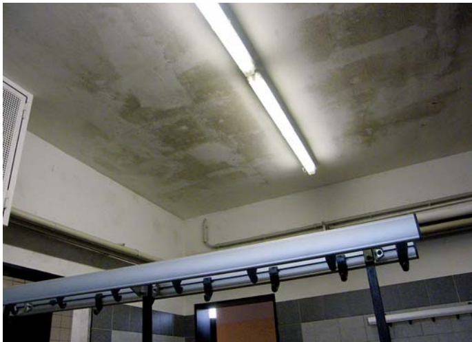
Unhaltbare Zustände: Die dringend sanierungsbedürftigen Umkleidekabinen am Schlangenberg verhindern bislang auch den geplanten Aufbau einer Mädchen-Mannschaft. Foto: Simons
