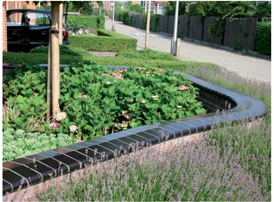
Nicht nur elegant, sondern auch funktional: Mauerabdeckungen schützen Klinker und Fugen vor eindringender Feuchtigkeit und daraus resultierenden Materialschäden.
