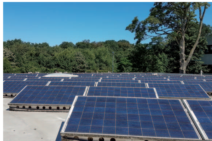
Die Photovoltaik-Anlage auf dem Dach des Langenfelder Unternehmens. Fotos (3): Stadt Langenfeld
