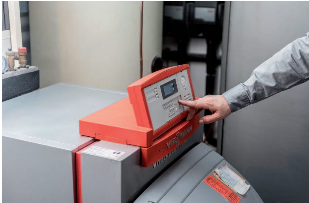
Moderne Brennwertheizungen sorgen für erhebliche Treibhausgas-minderungen.
