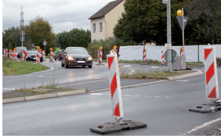
Zwischen Alfred-Nobel- und Langenfelder Straße entsteht gerade der neue Kreisverkehr. Unser Titelfoto zeigt übrigens den Beginn des Abrisses der Pavillons auf der Krischerstraße am 27. Oktober. Foto: Nobert Jakobs
