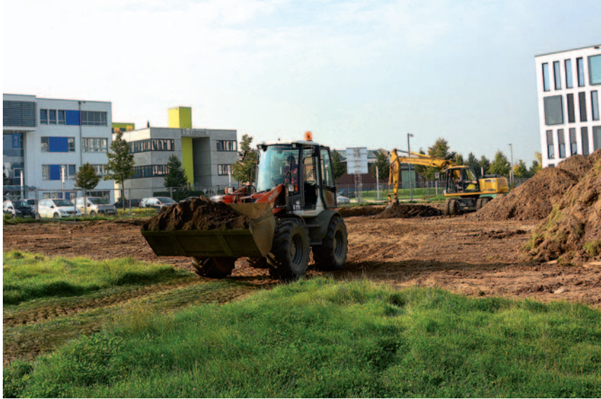
Die Erdarbeiten auf dem neuen Gelände der LF Europe GmbH im Rheinpark haben bereits begonnen. Im Hintergrund, mit dem gelben Mittelelement, das bereits bestehende Gebäude der chinesischen Firma. Links daneben E.T.-Technologies. Foto: Thomas Spekowius
