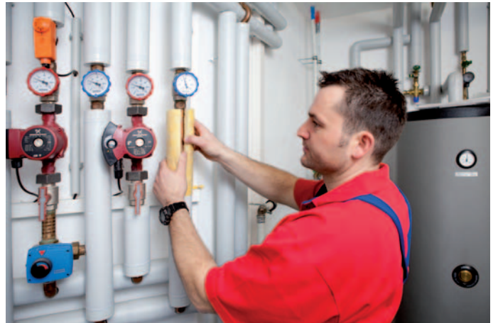
Gut isolierte Heizungs- und Warmwasserrohre sparen bares Geld.
