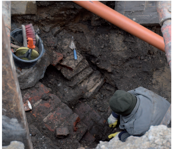
Mitarbeiter des Büros für Archäologie aus Köln untersuchen die Abwasseranlagen-Fundstelle nahe dem Zollhaus. Foto: Norbert Jakobs
