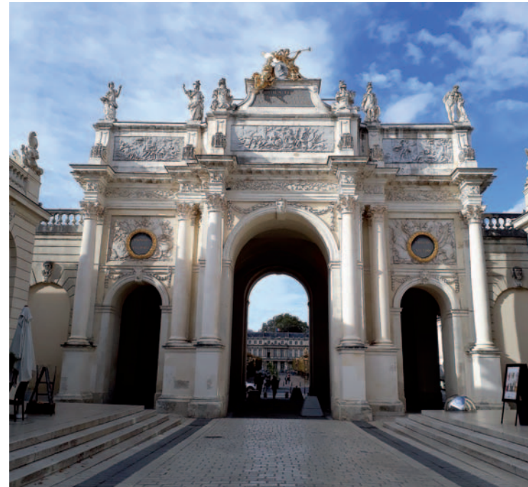
Der Triumphbogen „Arc Héré“, das nördliche Abschlussstor des Place Stanislas. Er wurde 1757 durch Stanislaus I. Leszczyński zu Ehren Ludwigs XV. errichtet.
