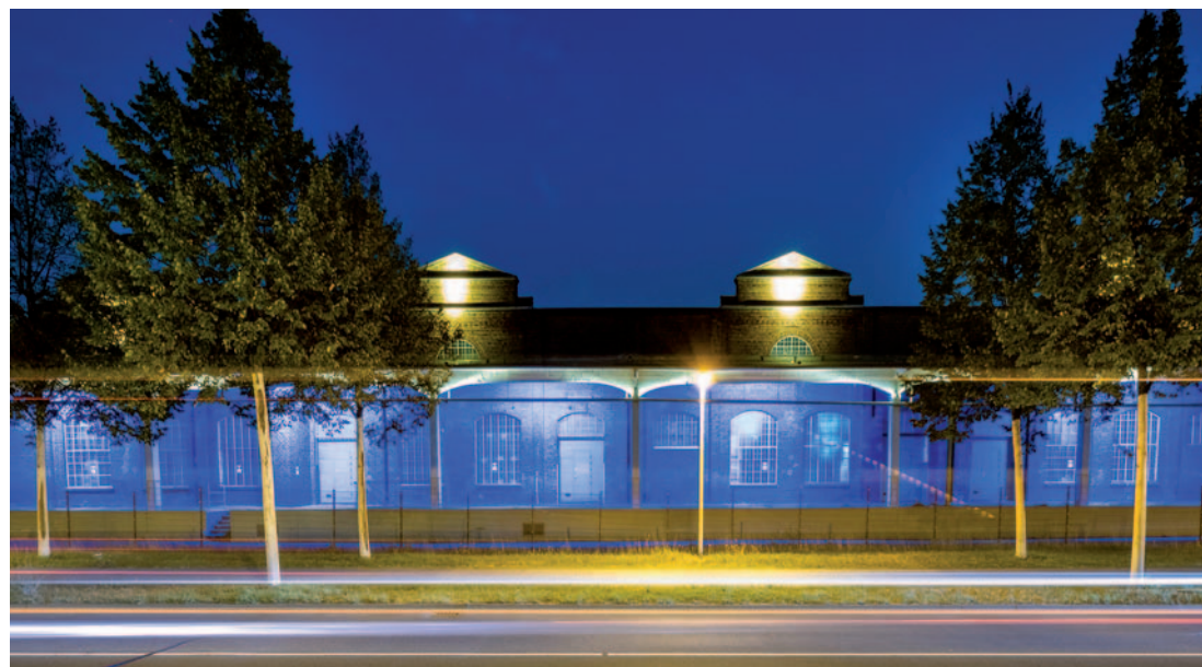
Die ehemalige Shell-Abfüllanlage am Rhein wird zur Festhalle. Foto: PETO30plus!
